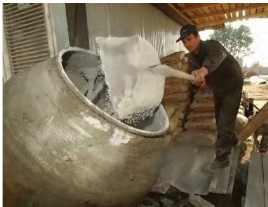
Мал. 2. Замішування цементного розчину
