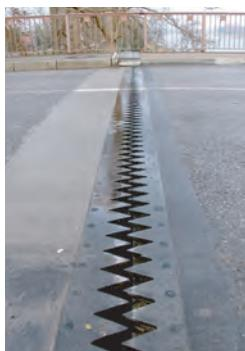
Рис. 4.2. Для забезпечення цілісності конструкцій передбачають можливість їх теплового розширення
